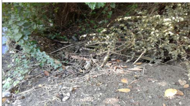
Foto: 1651753795447.jpg ID: 22 Presença de cicatriz de escorregamento pretérito, Formação de processo erosivo
