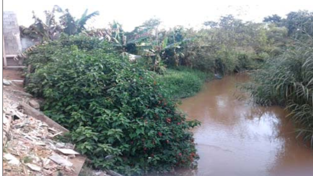
Foto: 1651602847206.jpg ID: 12 Visão geral da drenagem
