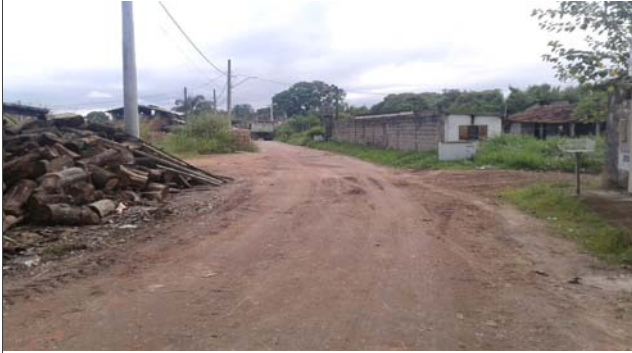
Foto: 1652366927060.jpg ID: 12 Visão geral da drenagem
