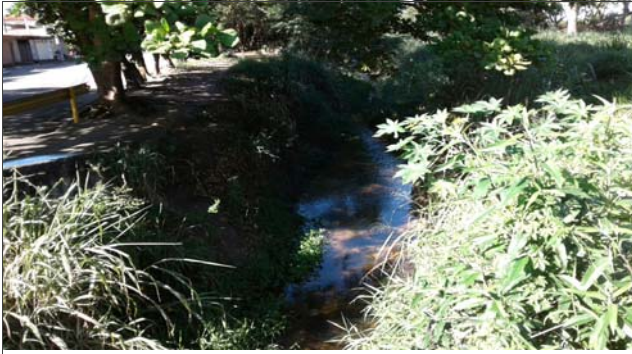
Foto: 1651752339951.jpg ID: 11 Visão geral da drenagem
