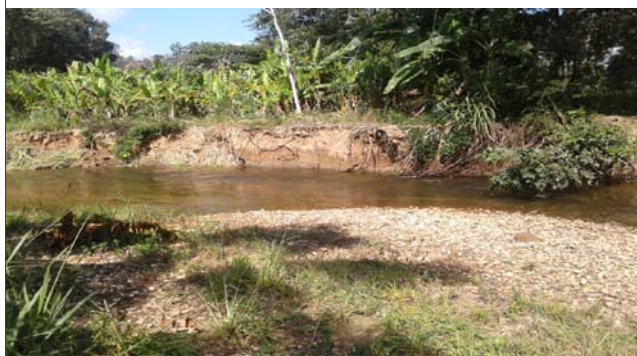
Foto: 1652103948197.jpg ID: 22 Visão geral da drenagem, Detalhe do canal
