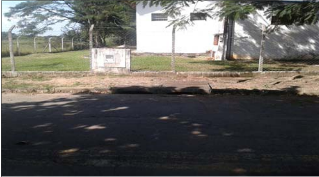
Foto: 1651596150590.jpg ID: 31 detalhe para intervenções no canal
