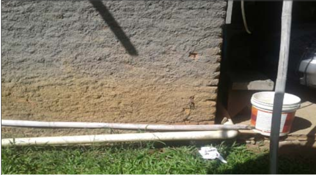
Foto: 1651502262016.jpg ID: 11 Imóveis afetados pelo processo, Detalhe para marca de água
