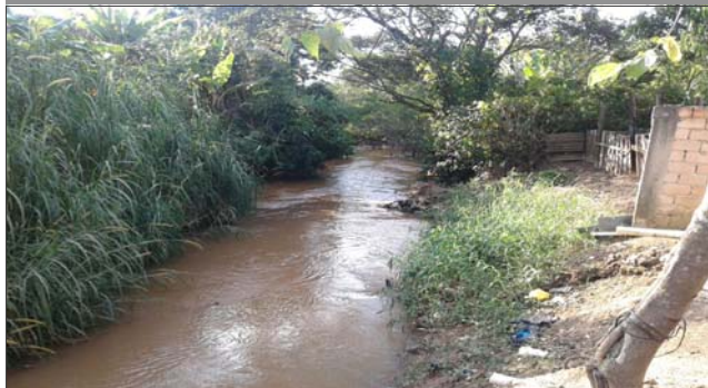
Foto: 1651602806946.jpg ID: 11 Visão geral da drenagem
