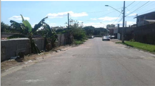
Foto: 1652114259735.jpg ID: 12 Visão geral da área, Limite da área atingida pelo processo
