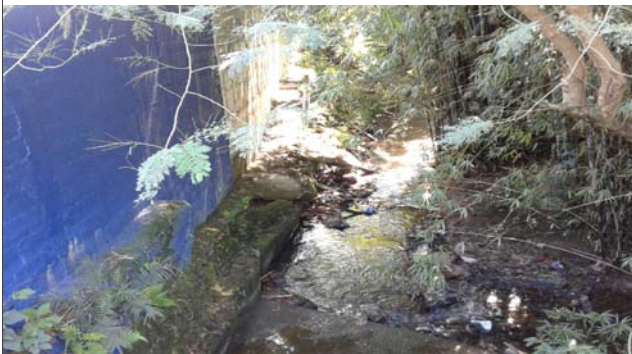
Foto: 1651502713957.jpg ID: 13 Visão geral da drenagem, Detalhe do canal
