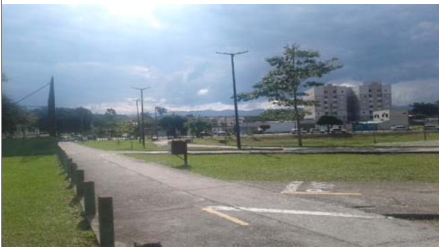
Foto: 1651511232963.jpg ID: 14 Limite da área atingida pelo processo, Imóveis afetados pelo processo
