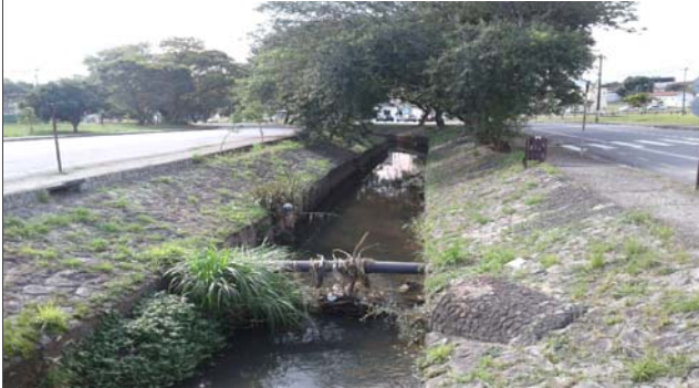
Foto: 1651511456011.jpg ID: 12 Visão geral da drenagem, Detalhe do canal, detalhe para intervenções no canal
