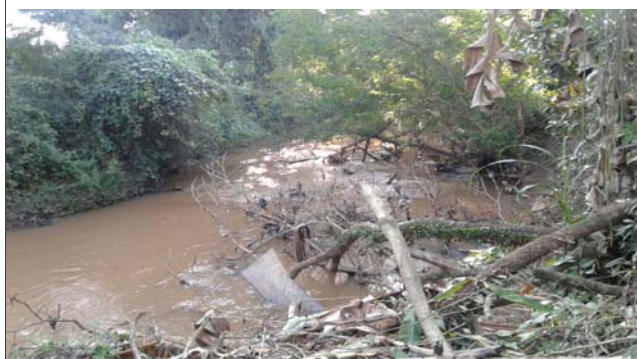
Foto: 1651604004507.jpg ID: 14 Visão geral da drenagem
