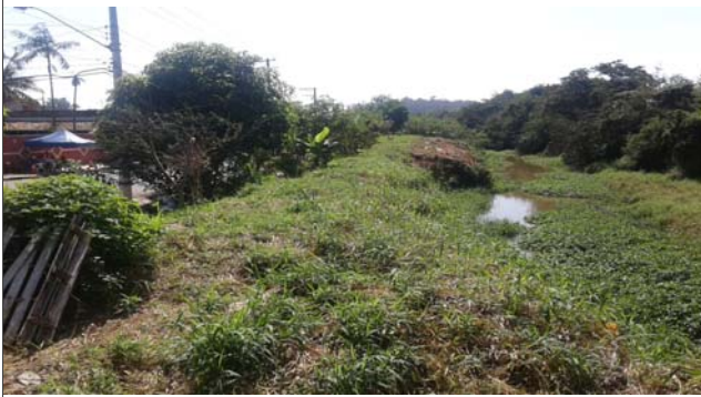
Foto: 1651586311947.jpg ID: 12 Visão geral da drenagem
