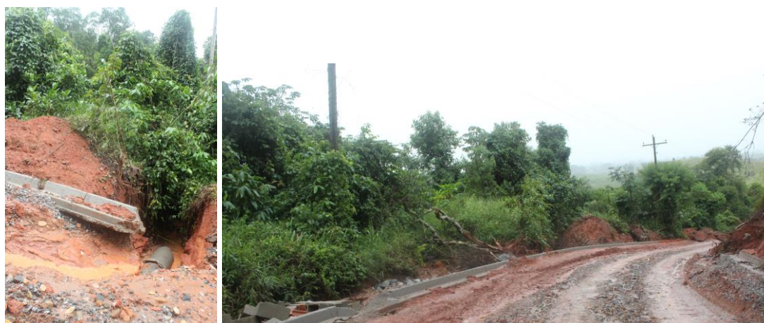
Figura 4 - 10. Obras na Estrada Municipal José Machado de Andrade (2013).
