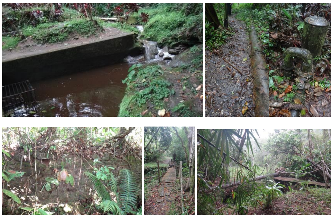
Figura 4 - 7. Características da Área Estratégica Interna 3 – Histórica Cultural. A) Caixa D'Água (represa). B) Tubulação e ponto com acúmulo de água na Trilha da Caixa D'Água. C) Aríete, também denominado como Bomba Carneiro. D) Ruínas do muro que, segundo funcionários, sustentava o Aqueduto. E) Ponte sem manutenção na Trilha do Aqueduto.
