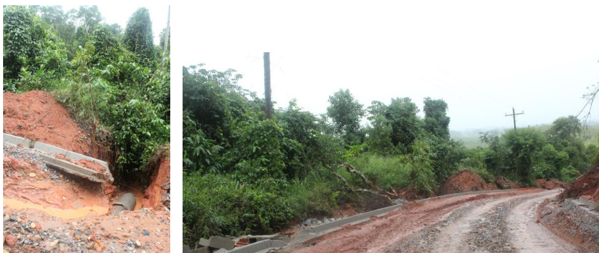
Figura 3 - 2. Obras na Estrada Municipal José Machado de Andrade é alvo de críticas durante Oficina de Planejamento do PNMT.
