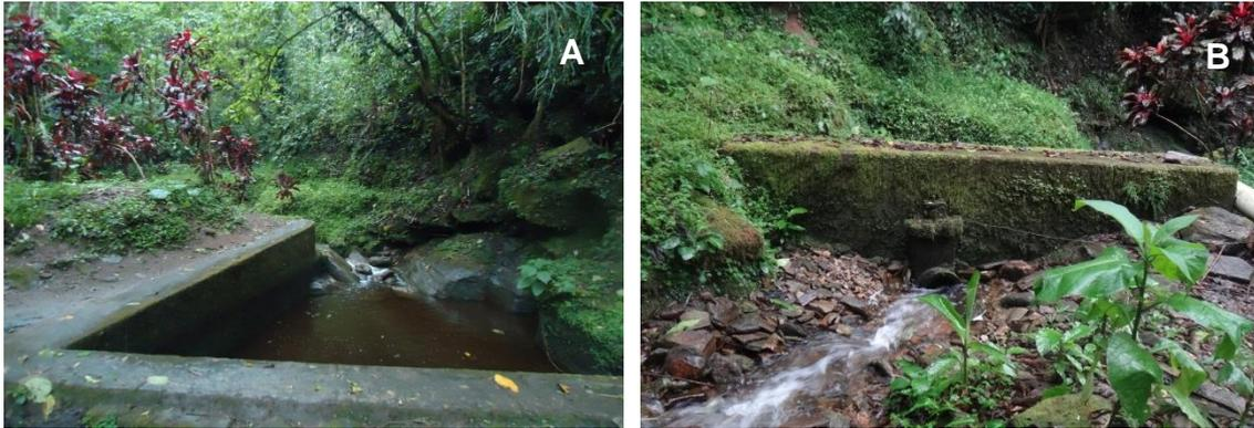
**Figura 3 - 54.** A) Caixa D'Água. B) Detalhe do sistema de captação da Caixa D'Água.
