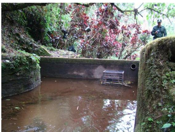
**Figura 3 - 21.** Barramento para captação de água no interior do PNMT, denominado "caixa d'água", sem registro de outorga no DAEE. Foto: Fabiano Nascimento Pupim.
