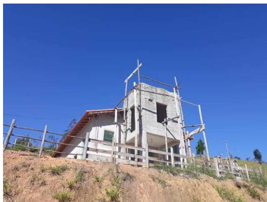
Foto 113: Capela São José
