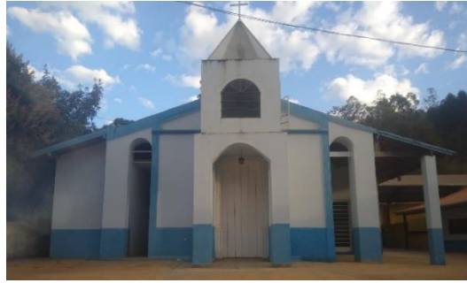
Foto 101: Capela São José
