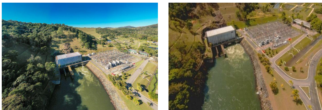
Foto 136: Usina Hidrelétrica Paraibuna
