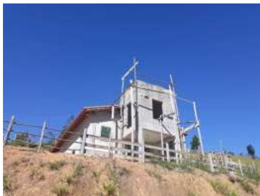
Foto 113: Capela São José
