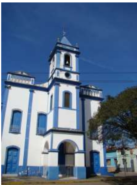
Foto 80: Igreja de Nossa Senhora do Rosário
