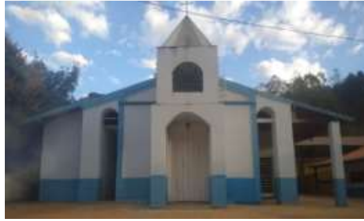
Foto 101: Capela São José
