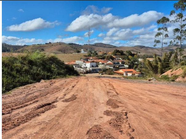
Foto nº 03- Área por outro ângulo da rua a ser pavimentada
