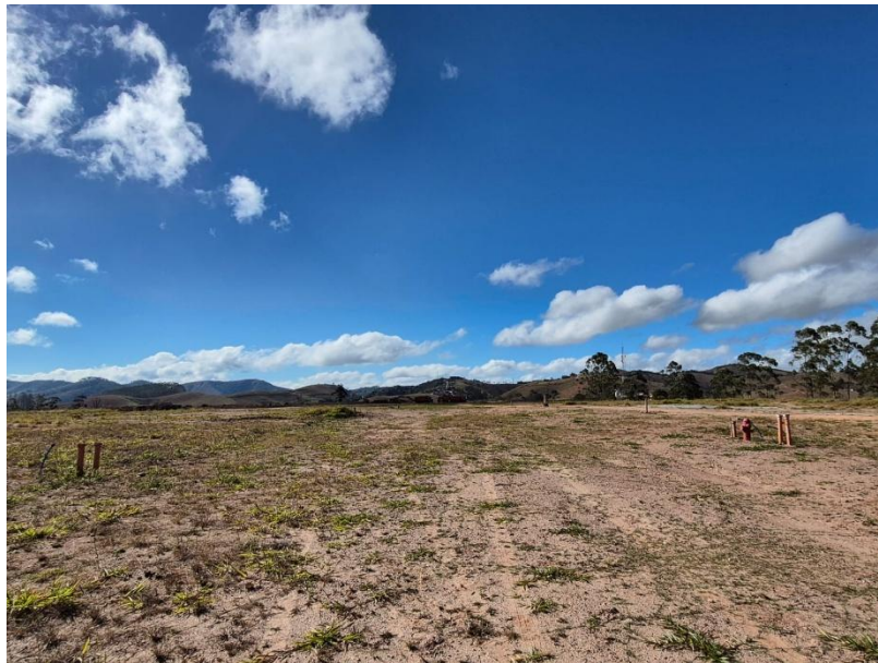
Foto nº 07- Vista da área a ser pavimentada
