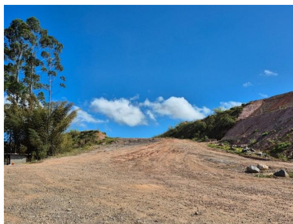
Foto nº 02- Vista do início da área a ser pavimentada
