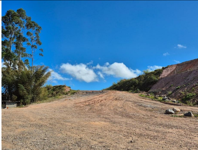
Foto nº 02- Vista do início da área a ser pavimentada
