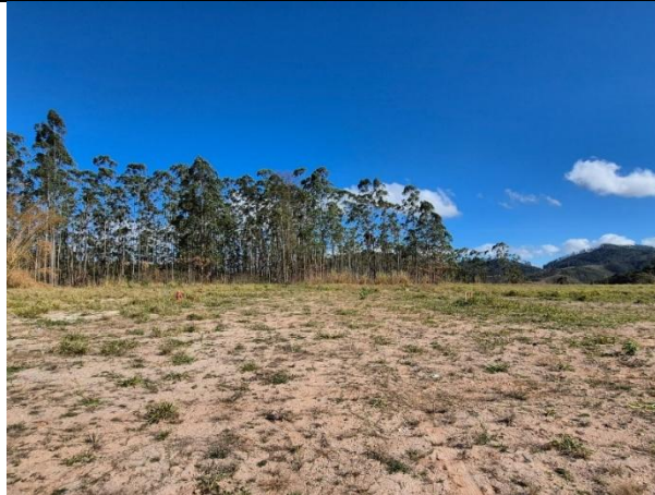
Foto nº 09- Fim da área a ser pavimentada
