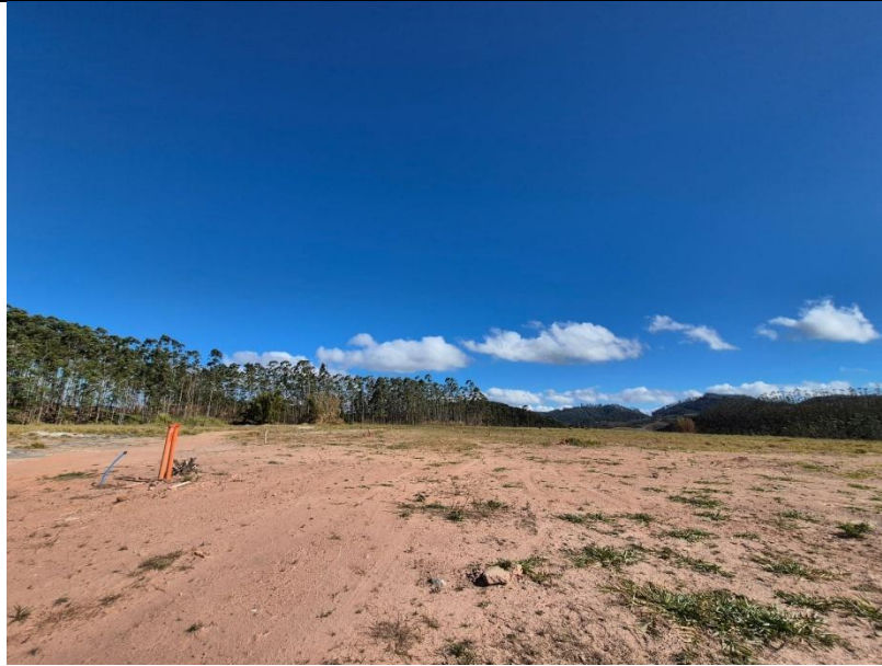
Foto nº 06- Vista por outro ângulo da área a ser pavimentada
