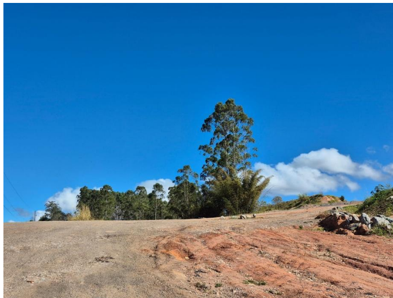
Foto nº 01 - Vista do início da área a ser pavimentada
