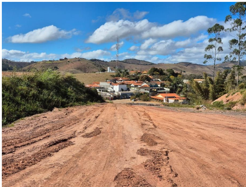
Foto nº 03- Área por outro ângulo da rua a ser pavimentada
