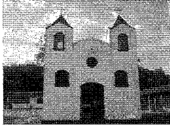
Capela do Bairro da Roseira
