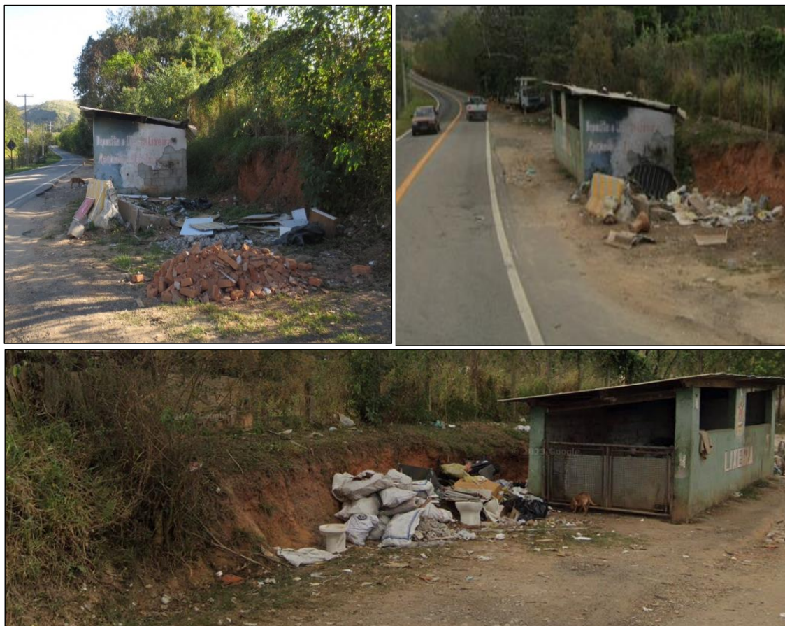
Figura 1 - Local de descarte irregular de materiais de construção. Fonte: Google Earth / Líder Engenharia e Gestão de Cidades, 2024.
