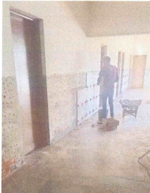
Assentamento do novo revestimento
