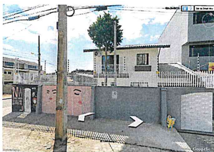
vista imóvel Av. Cedro (Google Earth)
