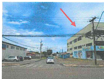
vista geral R. Espanha (CPAI)
