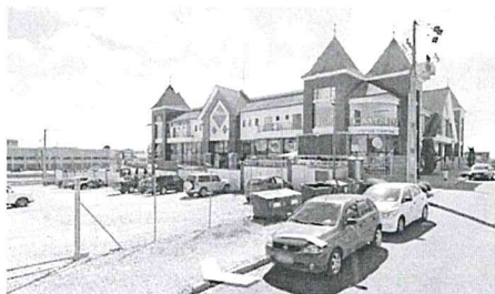
Fig.07: vista fundos imóvel (Google Earth)
