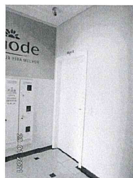
Fig.10: acesso sala 12 (CPAl)
