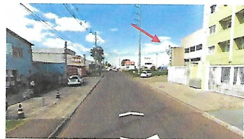
Fig. 06: vista geral Av. Cedro (Google Earth)
