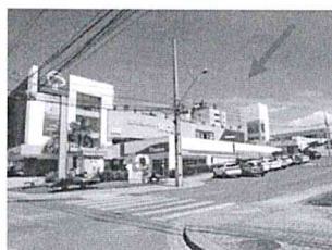
Vista geral imóvel (Google)
