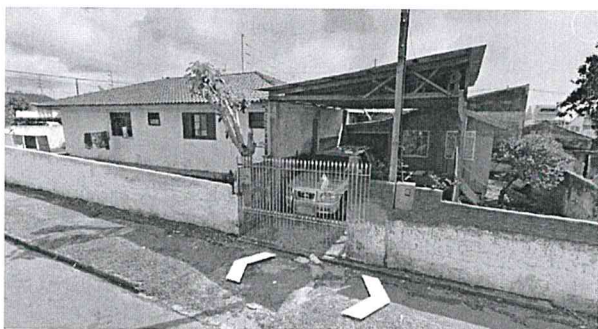
Vista geral Rua Goiabeira (Google)
