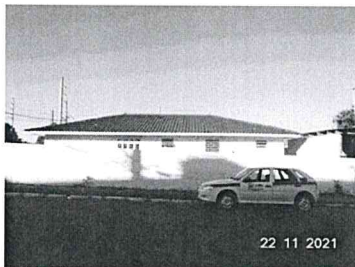
vista geral Rua Goiabeira (CPAI)
