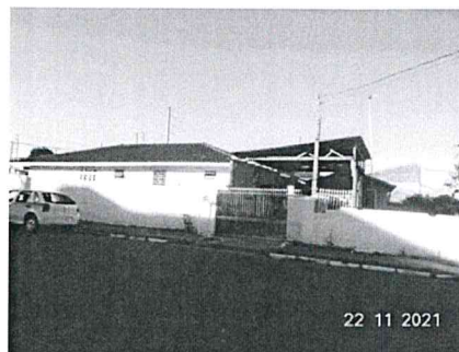
Vista geral Rua Goiabeira (CPAI)
