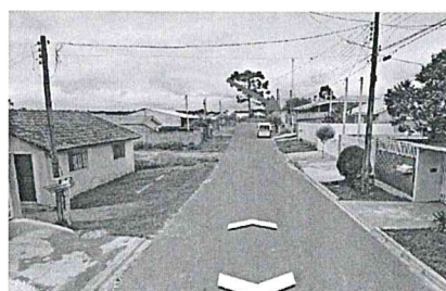
Vista geral R. Alemanha (Google)
