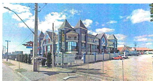
Fig.06: vista geral fundos imóvel (Google Earth)
