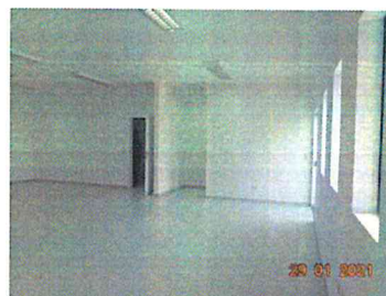
Fig.14: vista interna sala 12 (CPAI)
