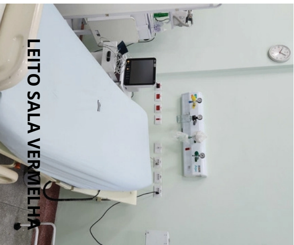
RÉGUA DE GASES SALA VERMELHA
