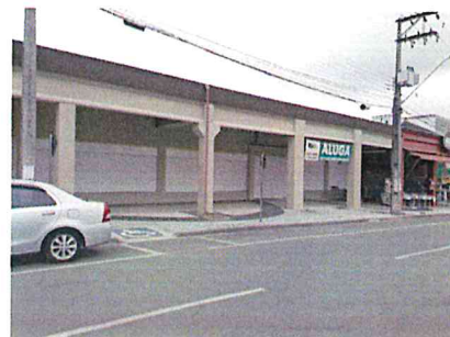
Foto 04: vista geral Rua Macedônia (CPAI)
