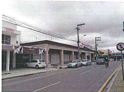
Foto 03: vista geral Rua Macedônia (CPAI)
