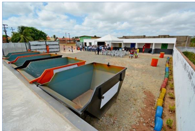
Figura 40: Vista da Disposição das Caçambas nos Ecopontos
