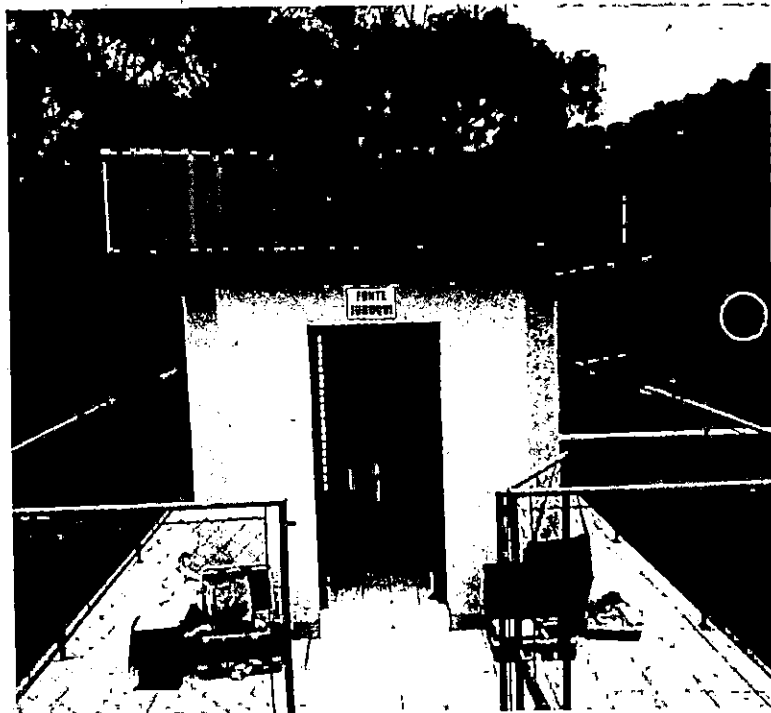
Foto 02 - Vista Externa da Casa de Proteção
