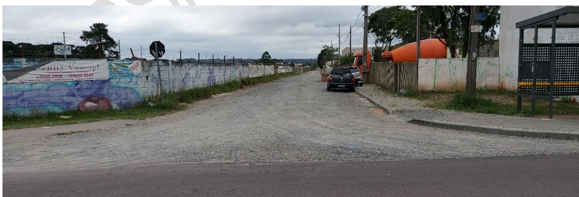
Figura 20: Rua em leito natural no bairro Pioneiros (R. Silvano José Baldan)
