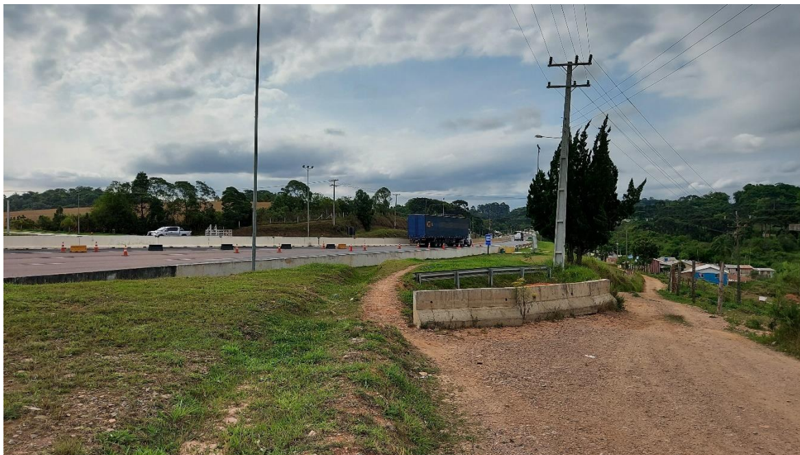
Figura 7: Acesso interditado do bairro Veneza à Praça de Pedágio no Km 134 da BR-116 em Fazenda Rio Grande
