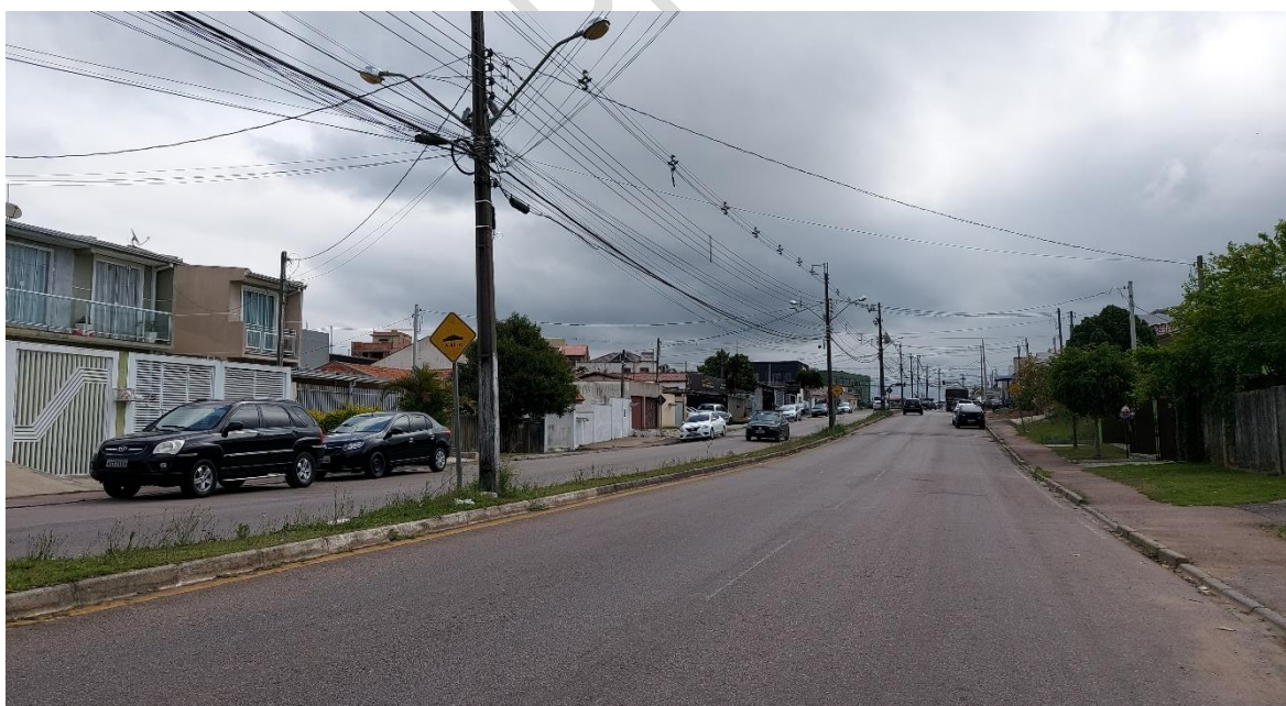
Figura 15: Via Arterial III (Av. Áustria)
