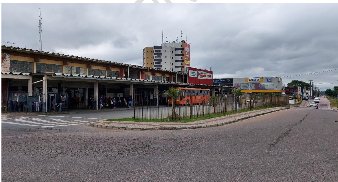
Figura 28: Parada de ônibus no terminal antigo de Fazenda Rio Grande
