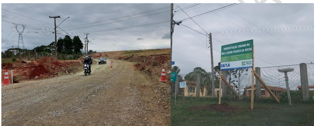
Figura 21: Obras de pavimentação no bairro Veneza (R. Lucinir Franco da Rocha)
