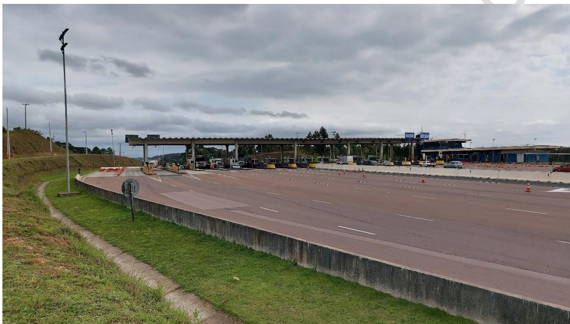
Figura 4: Praça de Pedágio no Km 134,4 da BR-116 em Fazenda Rio Grande
