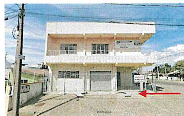
vista imóvel R. Sicupira (Google Earth)
