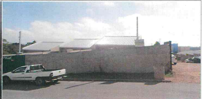
Frente do terreno para Rua Alagoas
