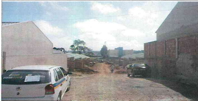
Frente do terreno para Rua Alagoas
