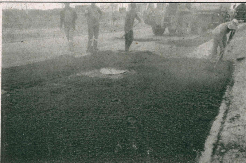
FOTO 07 – Rua Francisco Ferreira da Cruz – Pavimentação sendo executada na área de corte
