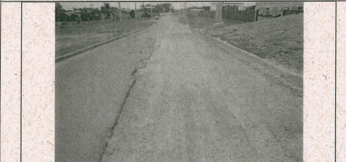
FOTO 01 – Rua Francisco Ferreira da Cruz – Efetuado corte na pista
