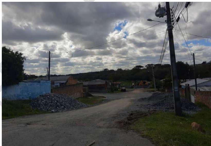
Figura 24: Obras de pavimentação no Bairro Iguaçu
