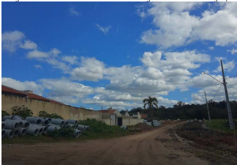
Figura 25: Obras de infraestrutura urbana na região das cavas do Rio Iguaçú
