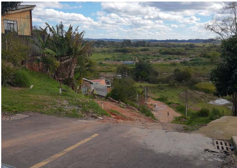
Figura 14: Precariedade de Infraestrutura nas Várzeas do Rio Iguaçu
