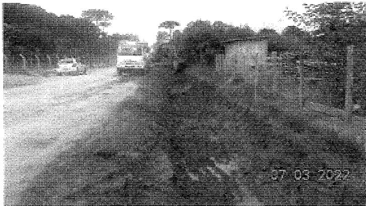
Imagem 6. Vala que necessita aterro, estaca 48 à 60
