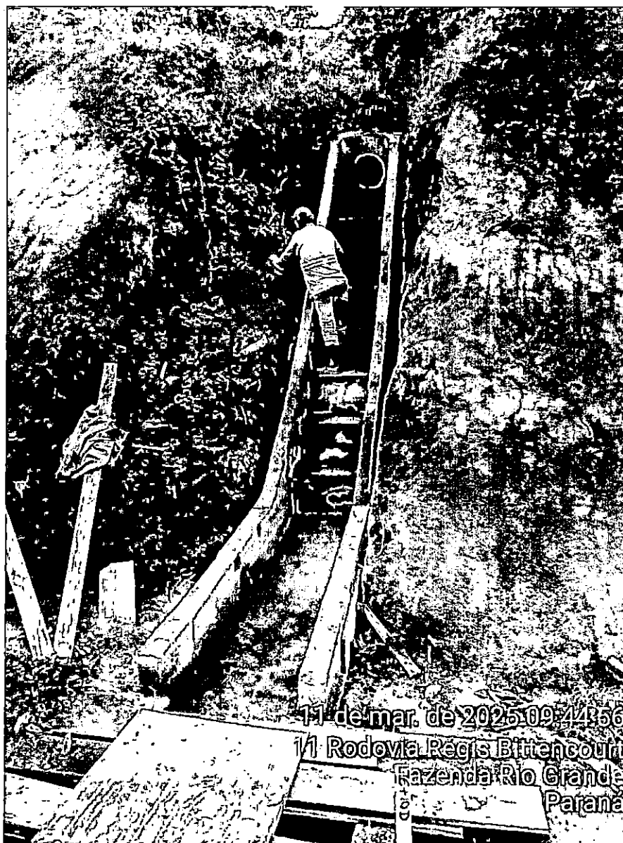
Figura 3 - Escada Hidráulica e Caixa de Queda
