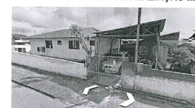
Vista geral Rua Goiabeira (Google)
