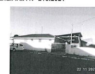
Vista geral Rua Goiabeira (CPAI)
