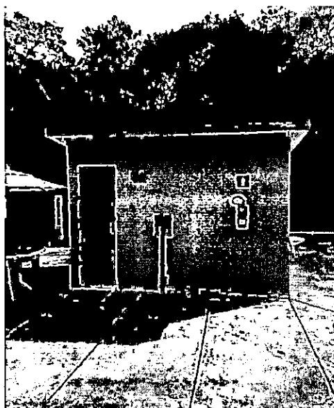
Casa de Proteção
