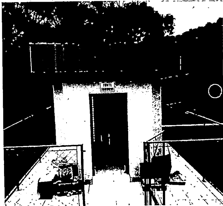
Foto 02 - Vista Externa da Casa de Proteção
