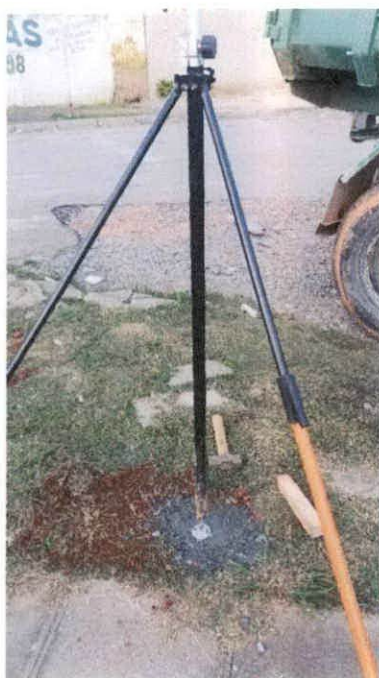
MARCO-001 Topográfico Rua Nossa Sr a . Aparecida Esq., Avenida Nossa Sr a . Do rocio.
