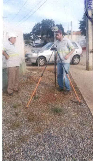
MARCO-004 Topográfico Avenida Nossa Sr a da Conceição
