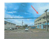
vista geral R. Espanha (CPAI)
