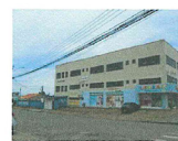
vista Rua Espanha (CPAI)
