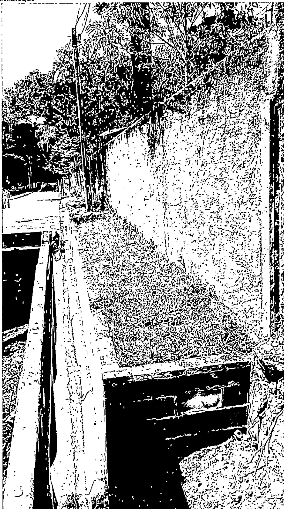
Figura 1: Muro de Arrimo
