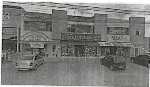
Fig.03: Rua Macedônia (Google Earth)
