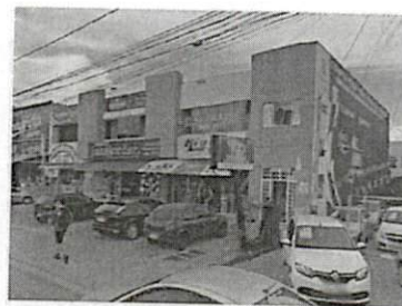
Fig.04: Rua Macedônia (Google Earth)
