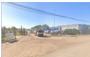
Figura 28: Vista do Acesso ao CGR Iguauçu
