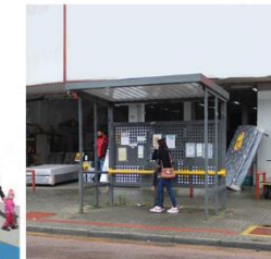
Parada de ônibus coberta em Fazenda Rio Grande Fonte: URBTEC™
