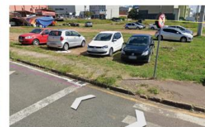
Calçada sem pavimentação adequada
