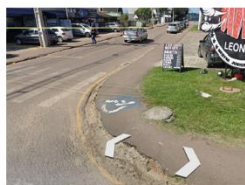
Rampa fora do padrão ABNT/NBR
