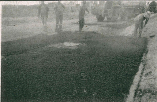
FOTO 07 – Rua Francisco Ferreira da Cruz – Pavimentação sendo executada na área de corte
