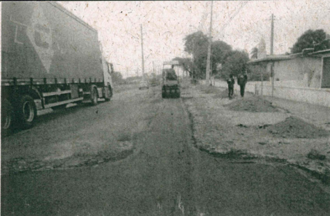
FOTO 09 – Rua Francisco Ferreira da Cruz – Pavimentação da área de corte
