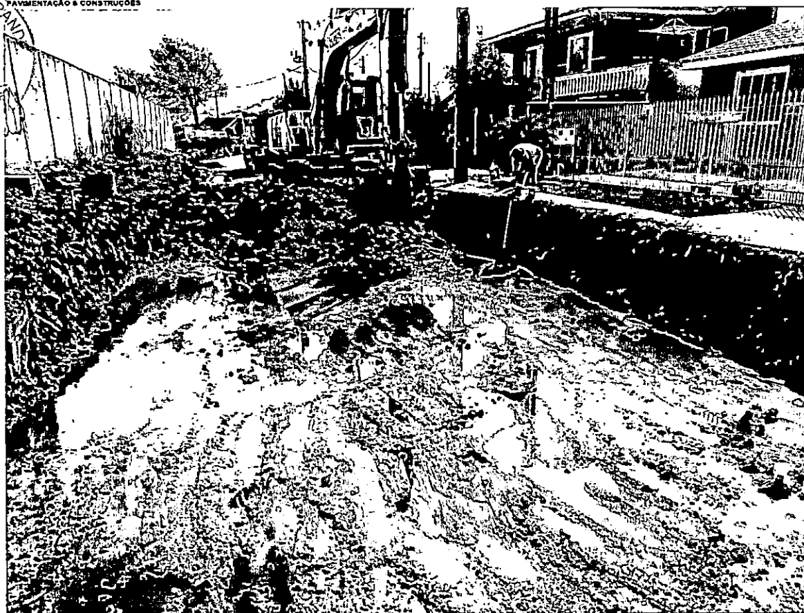
Foto 2: Fundo da escavação
