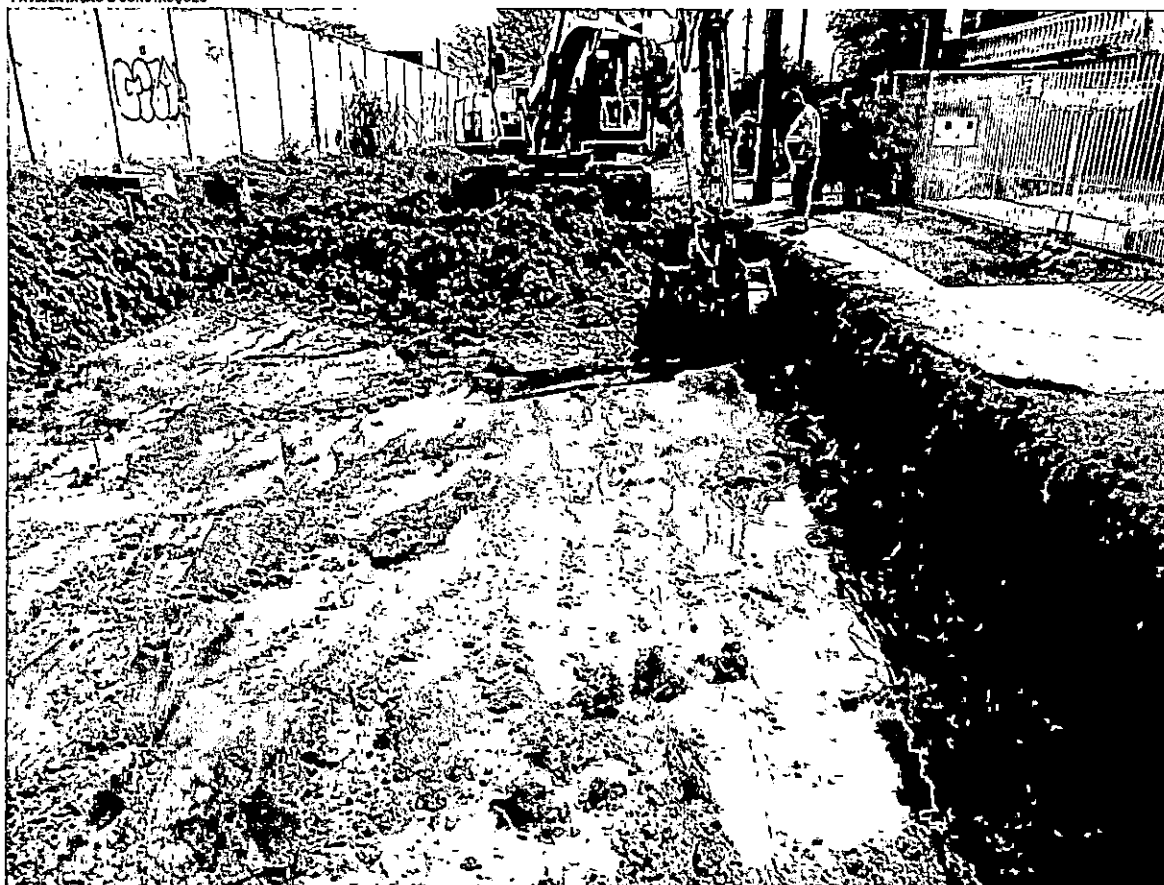
Foto 1: Fundo da escavação
