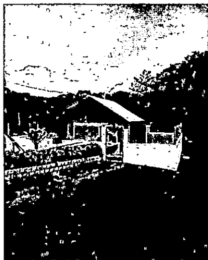
Casa de Proteção
