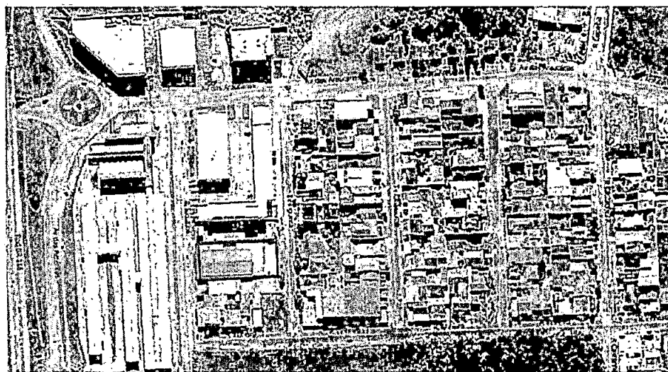
Localização (SEDU Paranacidade)
