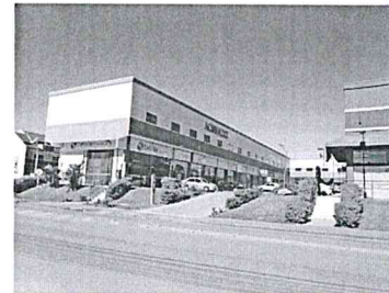
vista geral Av. das Araucárias (CPAI)
