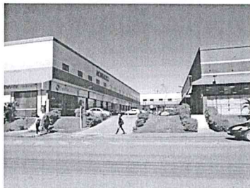
vista geral Av. das Araucárias (CPAI)
