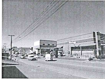
vista geral Av. das Araucárias (CPAI)
