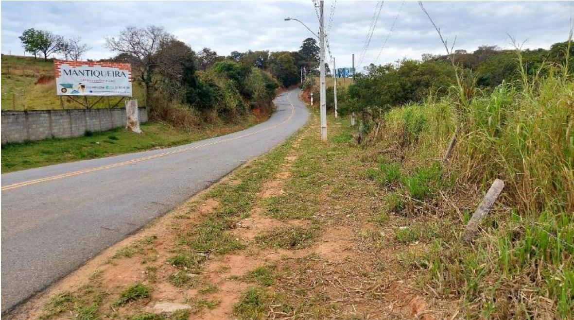
Foto 8-2 Vista da rua Mauro de Próspero olhando sentido Fernão Dias: Trecho com iluminação pública, asfalto e sem guia, sarjeta e calçada.
