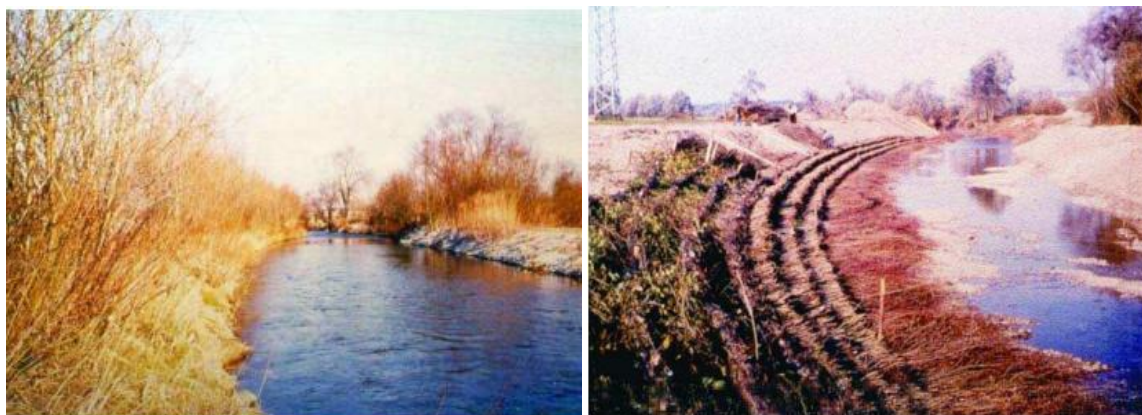
Figura 15.4- Proteção de margem: a) depois do crescimento de brotos. b) com instalação de faxinas de salgueiro.
