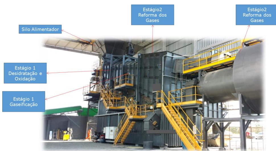
Figura 5 – 1º Gaseificador instalado, licenciado e em funcionamento no Brasil
