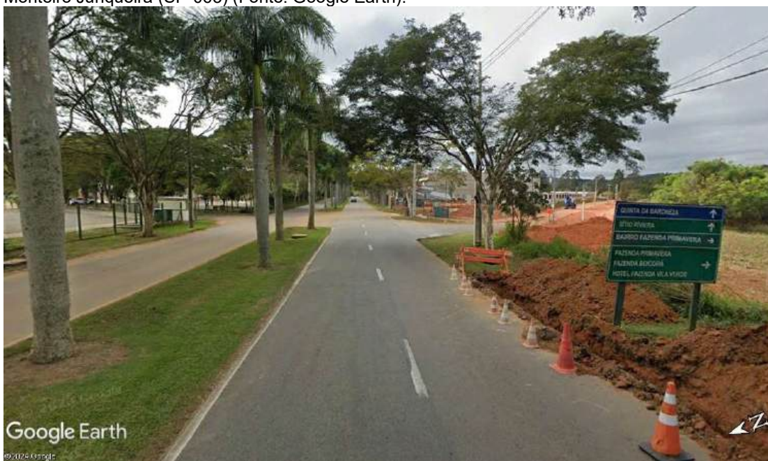
FOTO 02 – Estrada Municipal Antônio Olho Aro (BGP-260) (Fonte: Google Earth).
