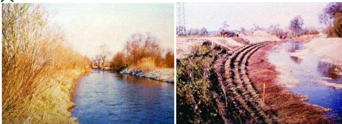
Figura 7.5- Proteção de margem: a) depois do crescimento de brotos. b) com instalação de faxinas de salgueiro.
