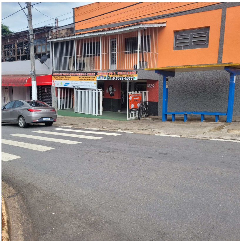
Foto: Ponto de ônibus da Av. Juscelino Kubitschek de Oliveira – Existência de abrigo em bom estado, guia rebaixada sem sinalização. Calçadas em bom estado. Não possui iluminação
