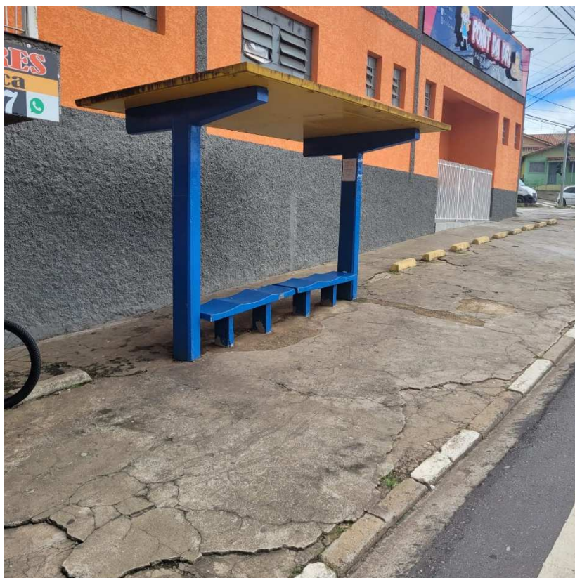
Foto: Ponto de ônibus da Av. Juscelino Kubitscheck de Oliveira – Existência de abrigo em bom estado, guia rebaixada sem sinalização. Calçadas em bom estado. Não possui iluminação
