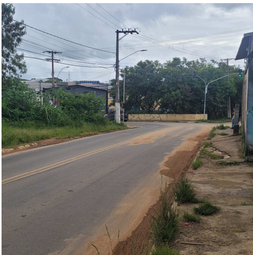
Foto: Ponto de ônibus da Av. Atílio Menin – Inexistente, porém os usuários esperam na calçada.
