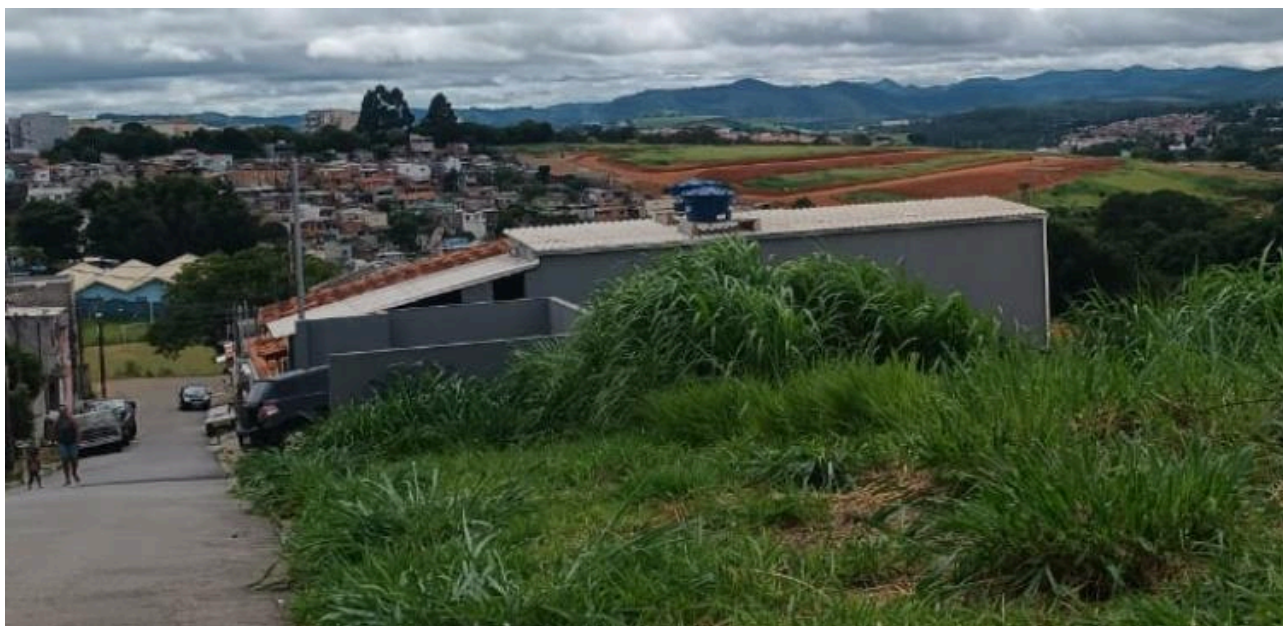
Loteamento em implantação (Jd. Nogueira) a 500 m do empreendimento
