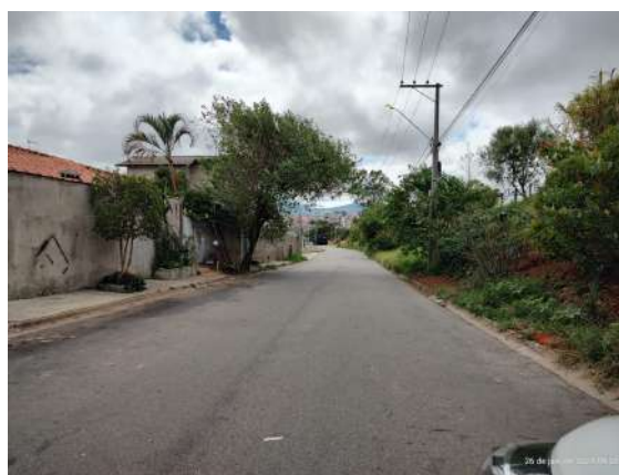
Figura 27 – Av. Engº Marcos A. A. Fleming, sem placas de regulamentação de velocidade
