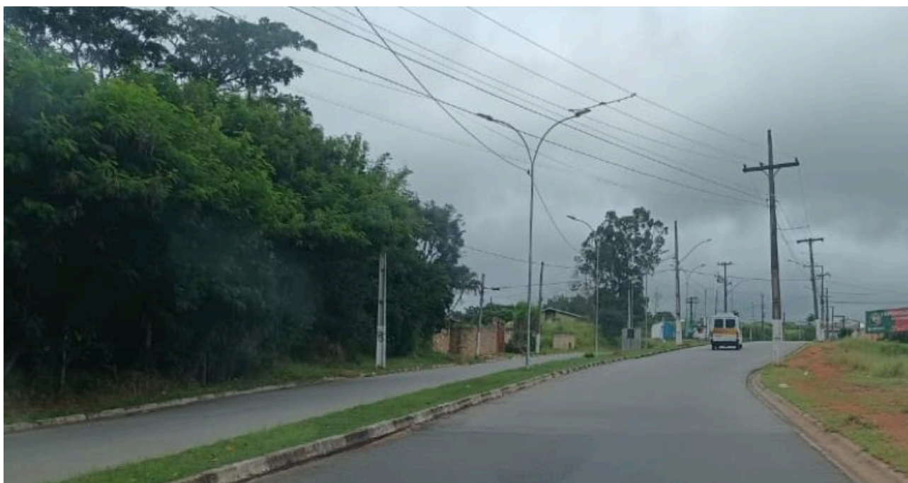
Trecho da Av. Dom Bosco duplicada
