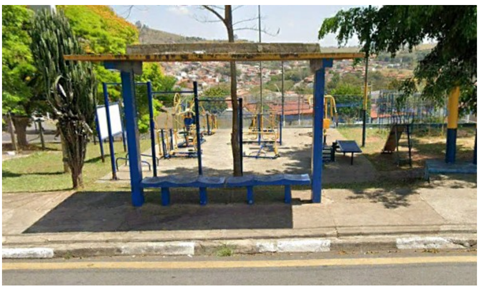
Foto de ponto de ônibus sem acessibilidade
