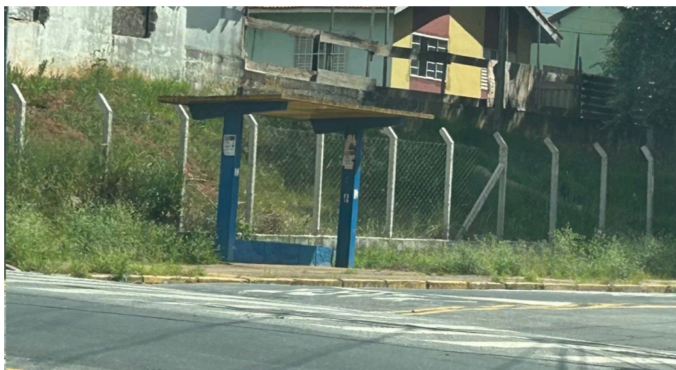
Imagem 44: Ponto de ônibus na Avenida Minas Gerais Data:20/03/2024
