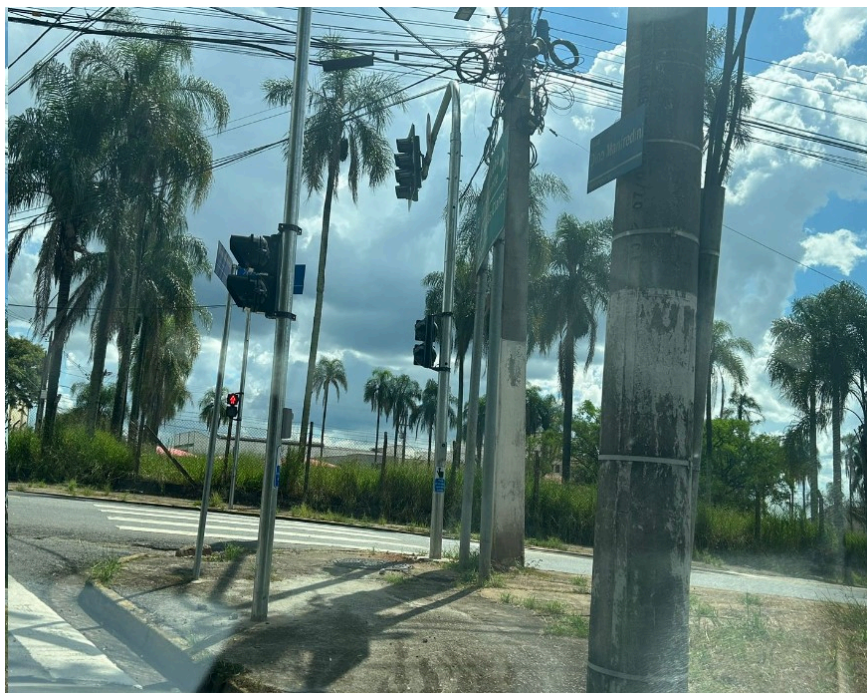
Imagem 30: calçada no cruzamento da Alameda XV de novembro x Avenida Dino Manfredin . Data: 20/03/2024
